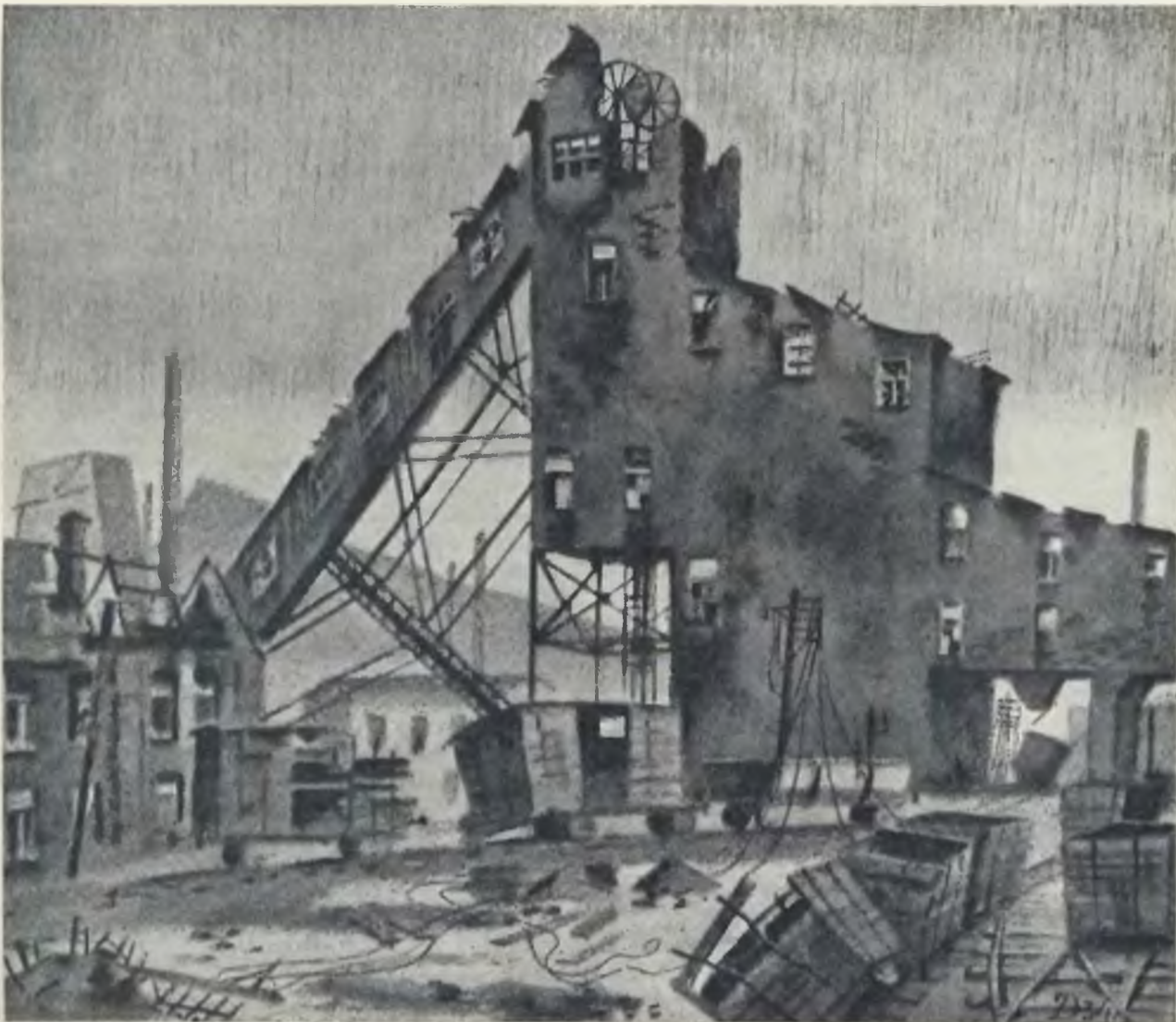
Разрушенная и покосившаяся шахта. Рис. Н. Дормидонтова.
