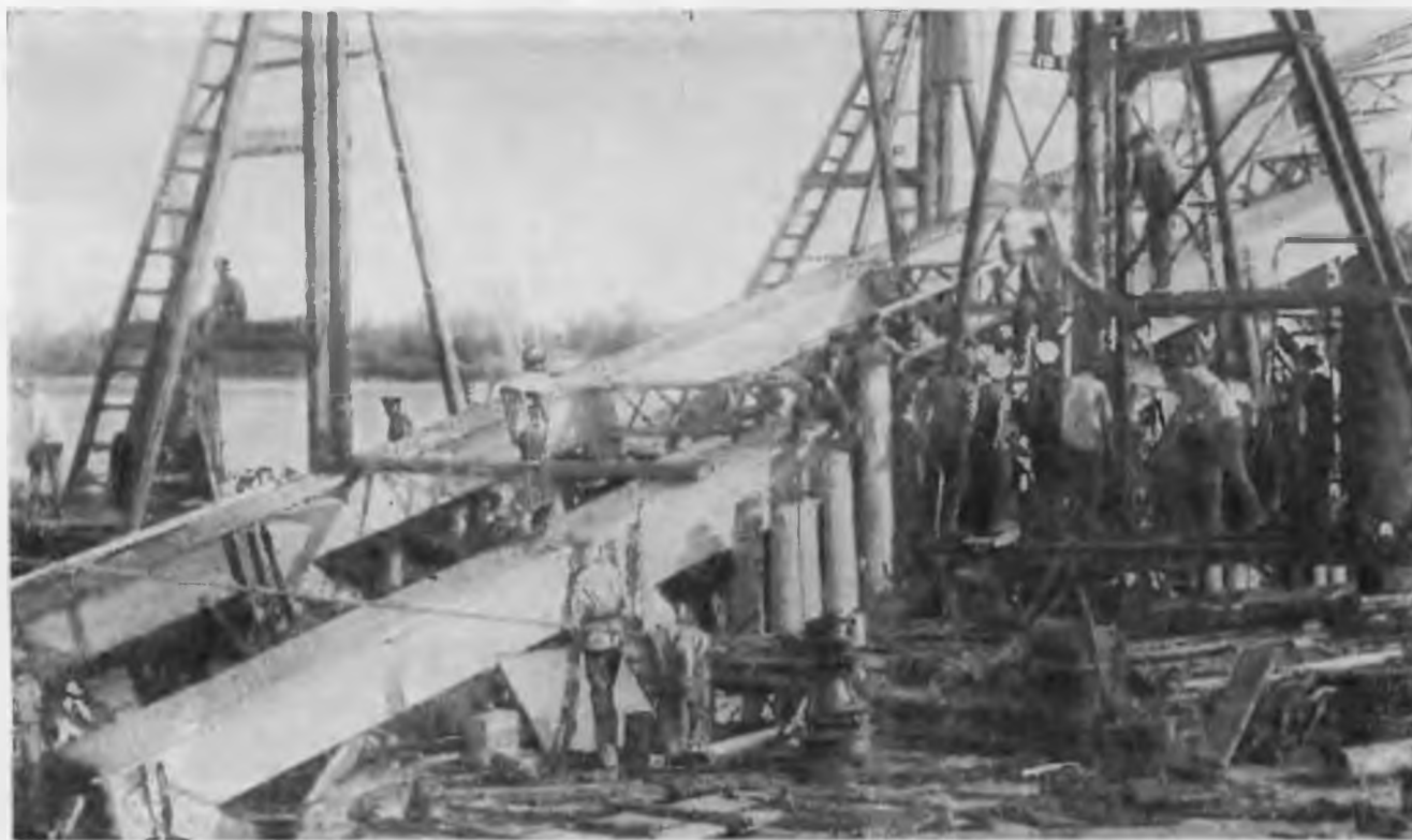
Восстановление железнодорожного моста через реку Белую, взорванного колчаковцами при отступлении на Уфы. 1919 г. (Фото.)
