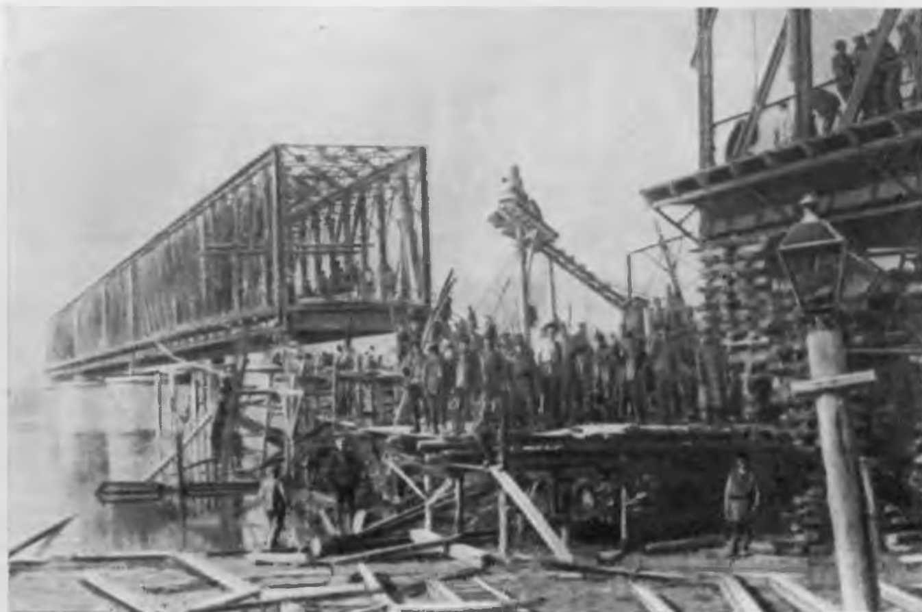
Восстановление железнодорожного моста через реку Кубань под Екатеринодаром (Краснодар). 1920 г. (Фото.)
