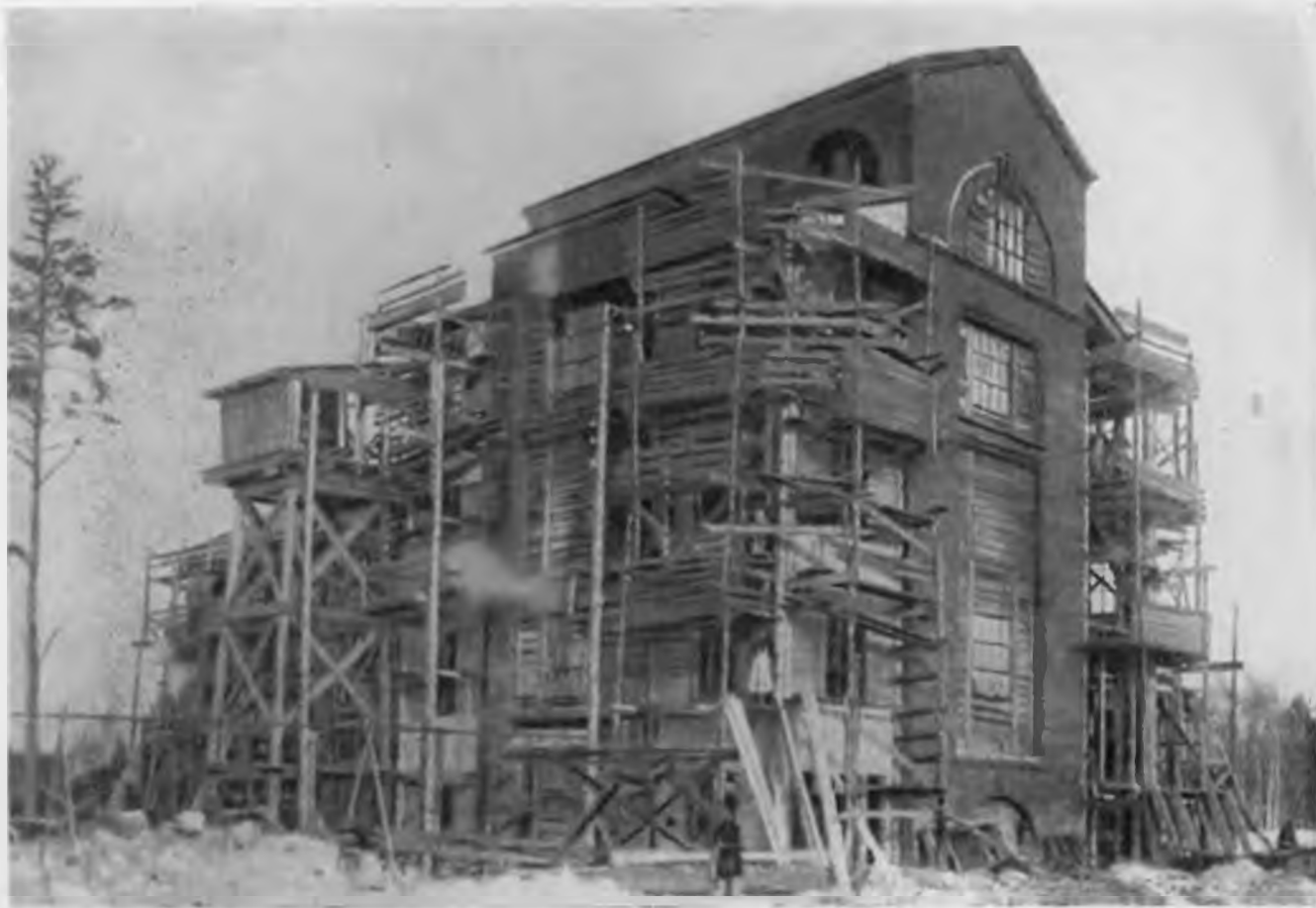
Строительство подстанции Шатурской ГЭС. 1920 г. (Фото.)
