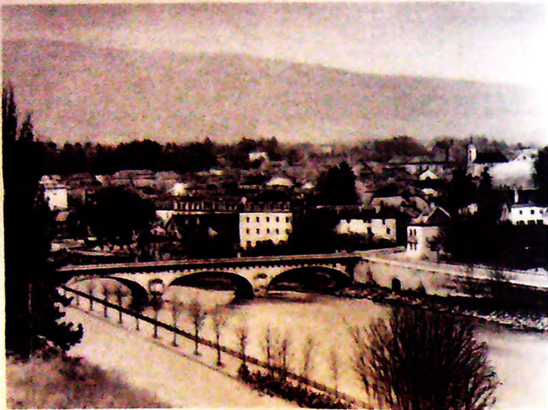
Мост через реку Арву
