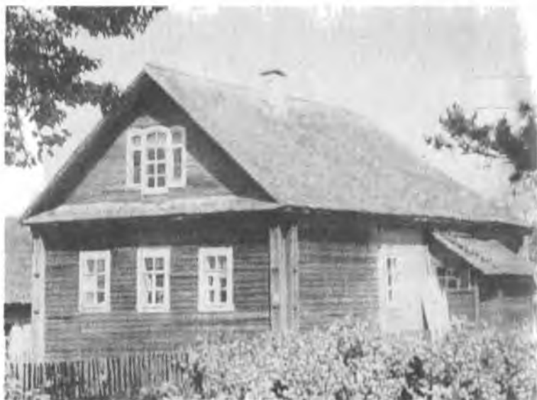
Дом на станции Валдайка
