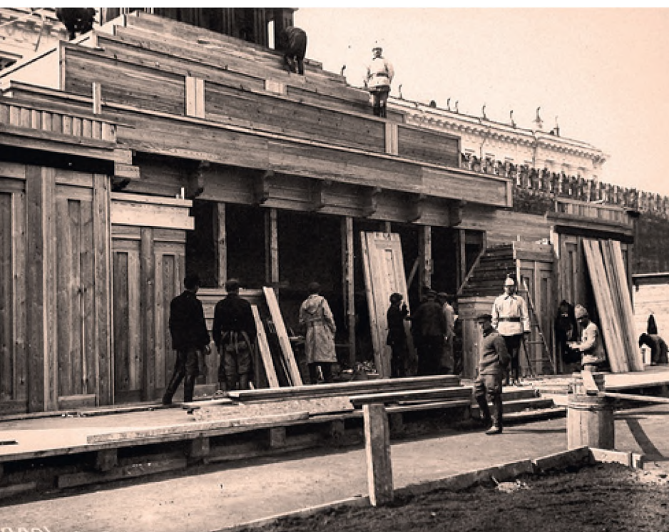
Строительство второго деревянного Мавзолея
