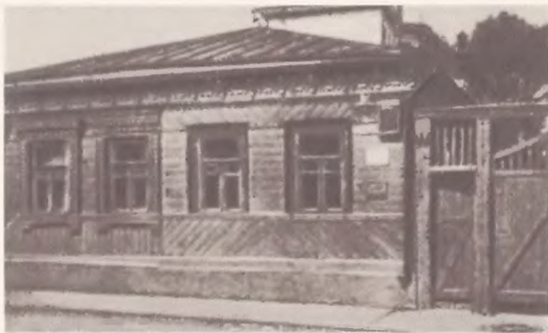
Здание, в котором размещался ВРК Пресненского района Москвы
