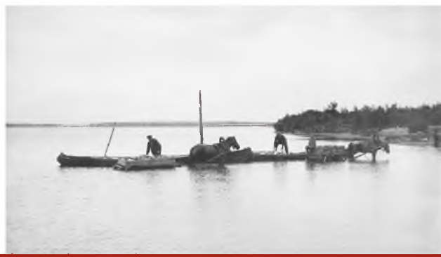
Перевозка гранитных блоков 1927 г.
