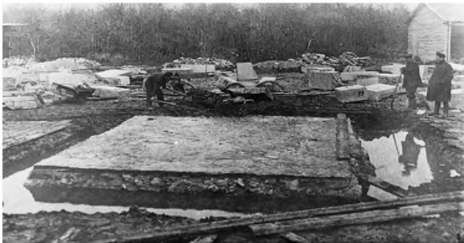
Установка железобетонной плиты фундамента 1927 г.
