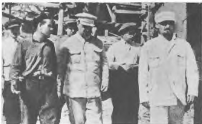
Г. К. Орджоникидзе на строительстве Луганского паровозостроительного завода. 1934 г.
